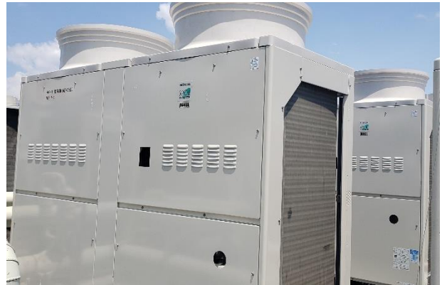
設備の省エネルギー化(4) 高効率機器への更新(冷凍機)
